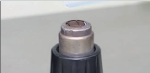
3. 튜브에 너트를 삽입 후 튜브의 끝을 HEAT GUN을 사용하여 가열
